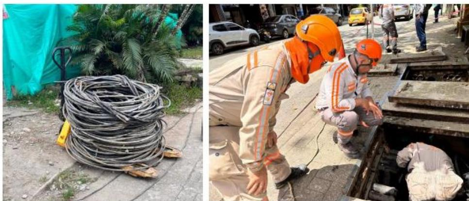
*200 metros de cableado subterráneo se afectaron por el corto circuito generado por una conexión irregular.*
