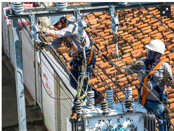
Trabajos de Celsia en el Tolima / Cortesía Celsia
