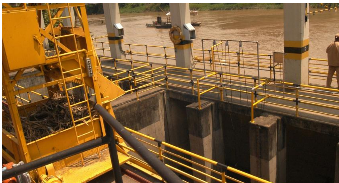
Planta de agua Puerto Mallarino.
