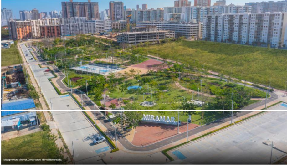
Megaproyecto Miramar, Constructora Marval, Barranquilla.
