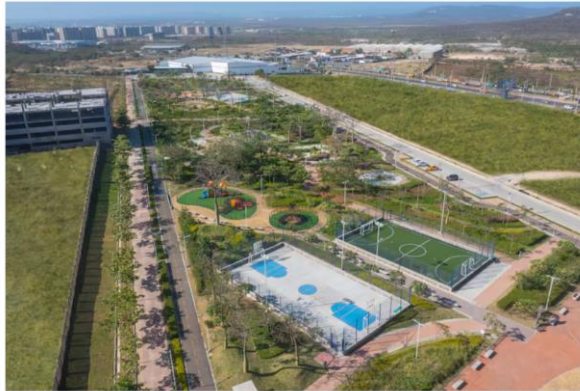
Mejoramiento Miramar: Constructora Marval, Barranquilla. Megaproyecto Miramar: Constructora Marval, Barranquilla.
