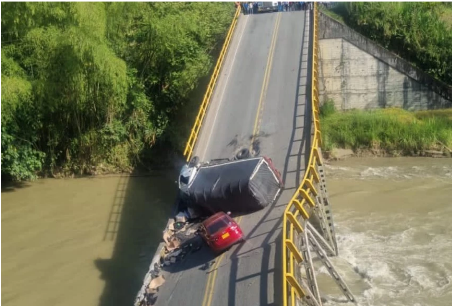
Puente El Alambrado
