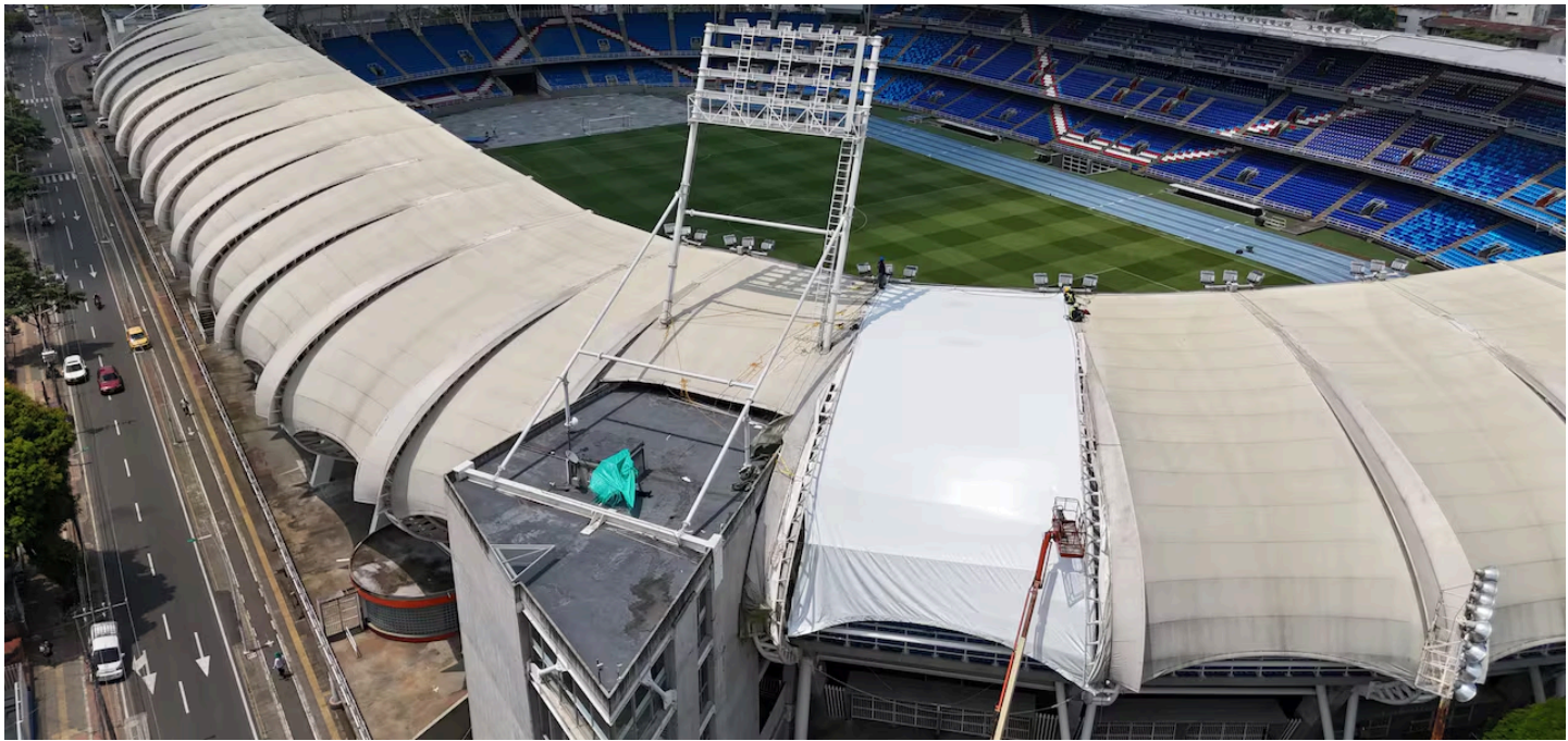
Con la intervención de estos dos parques se han recuperado más de 4500 metros cuadrados de espacio público en la Comuna 13, lo cual equivaldría a la mitad de la zona del estadio Pascual Guerrero. | Foto: Alcaldía de Cali
