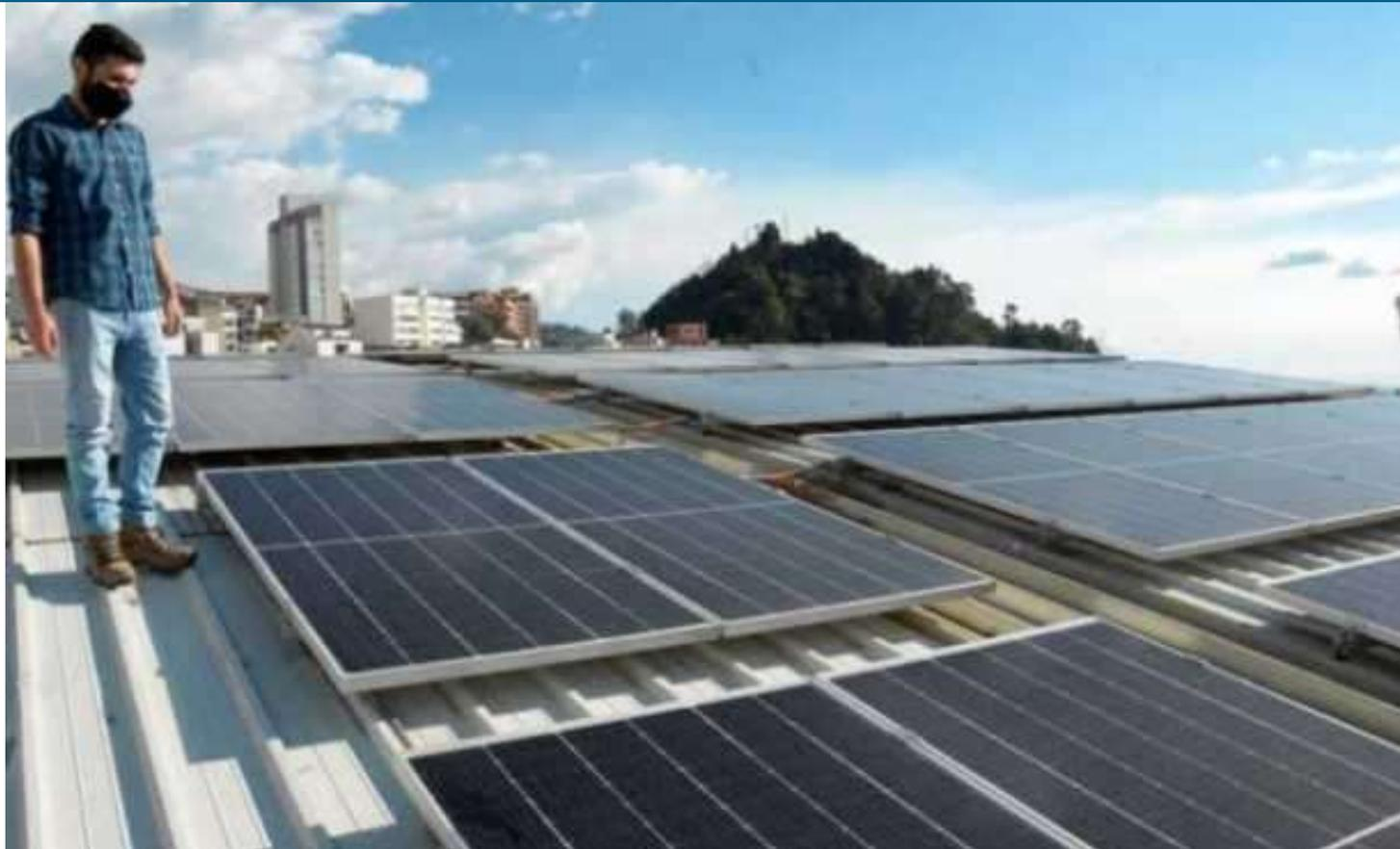
Foto | Freddy Arango | LA PATRIA Paneles fotovoltaicos en el techo de Mercaldas de Palermo, instalaron 252, cada uno de 2 metros cuadrados.
