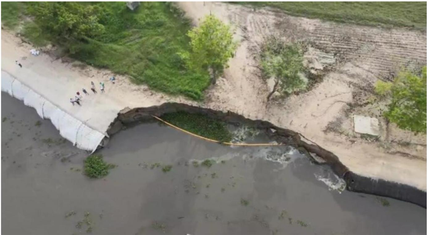
La erosión sobre la vía-dique que une a los municipios de Salamina y El Penón, en Magdalena, causó el colapso del kilómetro 2.1 de la carretera. / Foto: Cormagdalena.
