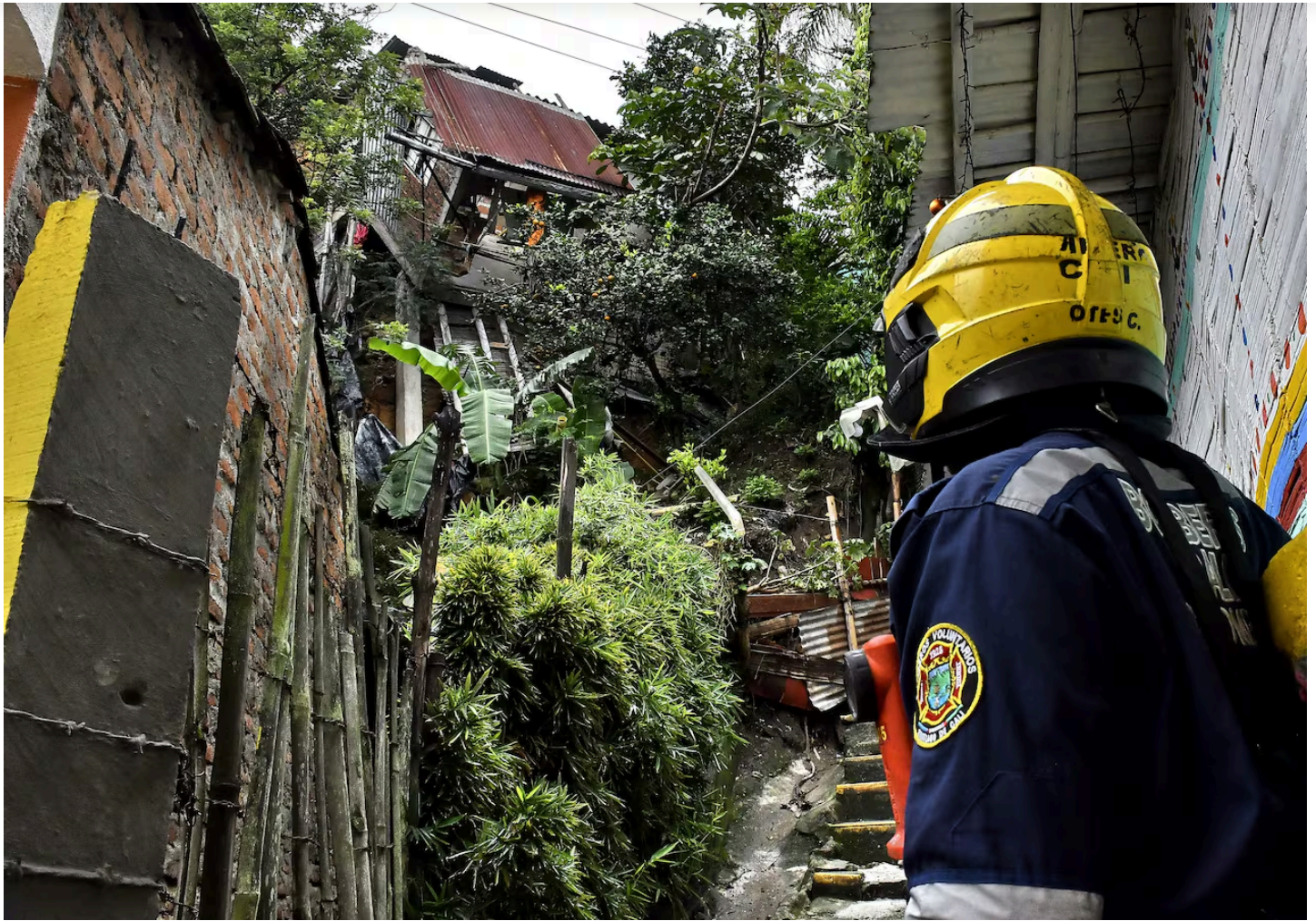
Emergencia en Siloé por el colapso de una casa tras deslizamiento de tierra. | Foto: Raúl Palacios
