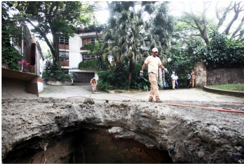
Desvíos en la Av. Circunvalar debido a un cráter que se formó por la ruptura de un tubo del alcantarillado en la Av. 5 con 3
