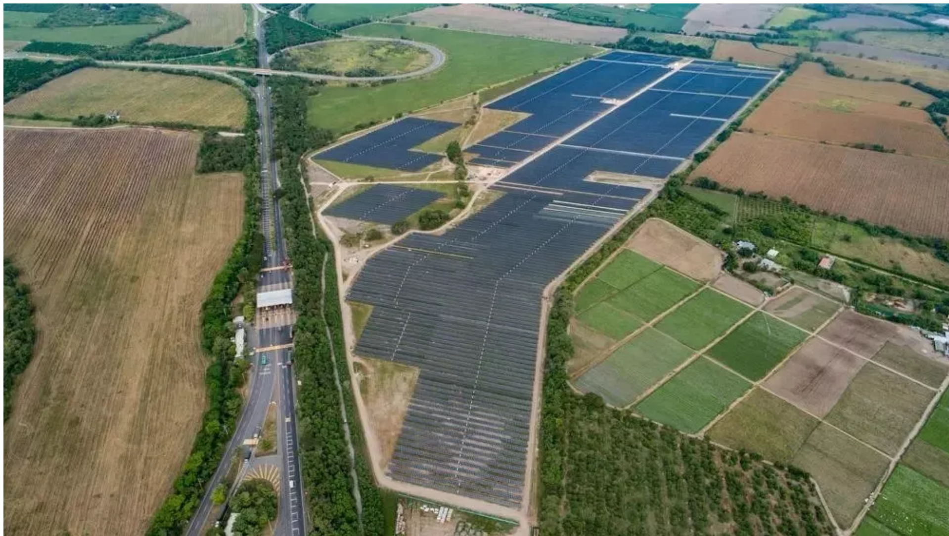
Las granjas solares de Celsia en el Tolima están ubicadas en Melgar, San Felipe y Flandes
