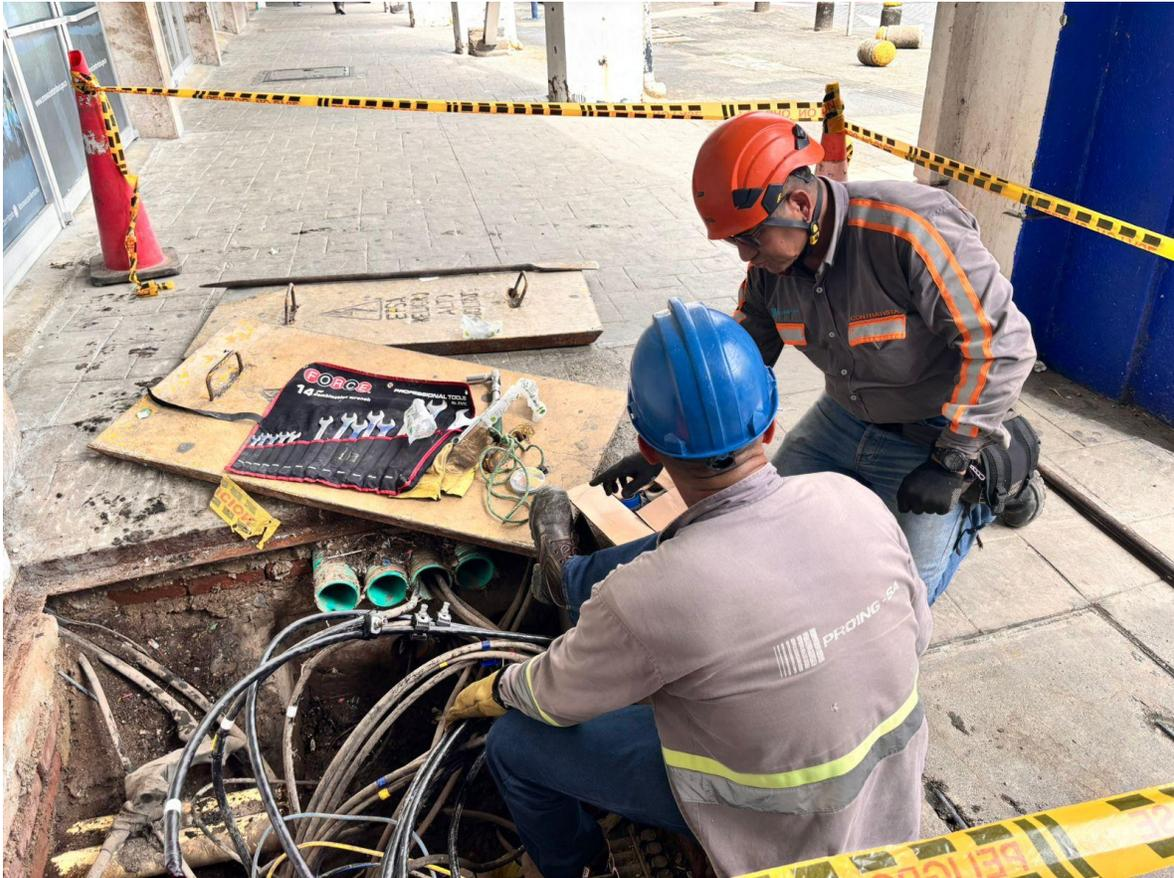
Celsia se encuentra en la última de 4 etapas del proceso de modernización de las redes de media y baja tensión en el sector del malecón, el cual presentaba una sobre carga debido al aumento de la demanda de energía, conexiones antitécnicas y afectaciones de la infraestructura por la alta salinidad que hay en Buenaventura.
