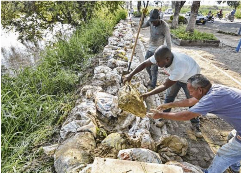
En el malecón de Juanchito, sobre la vía Candelaria - Cali, varios trabajadores y vecinos de la zona hicieron un muro con costales de arena para evitar una inundación. Bernardo Peña y Jorge Eliecer Orozco/ El País
