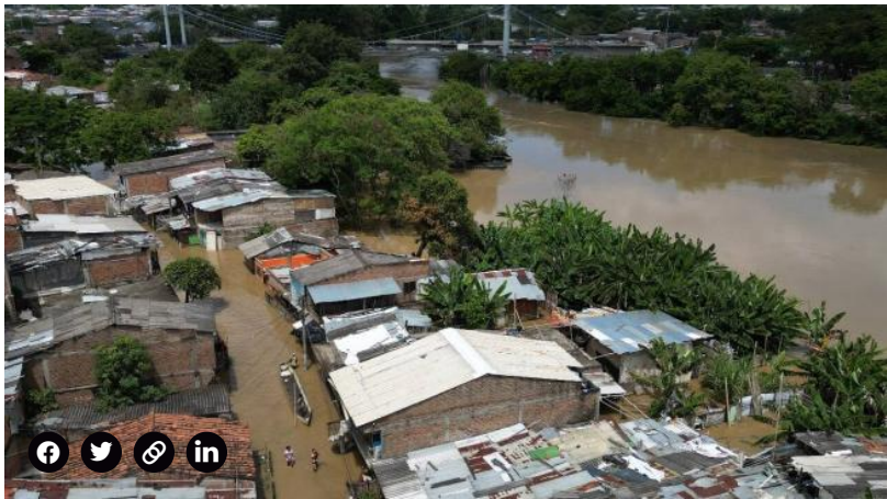
Se reportan inundaciones por desbordamiento del río Cauca.
