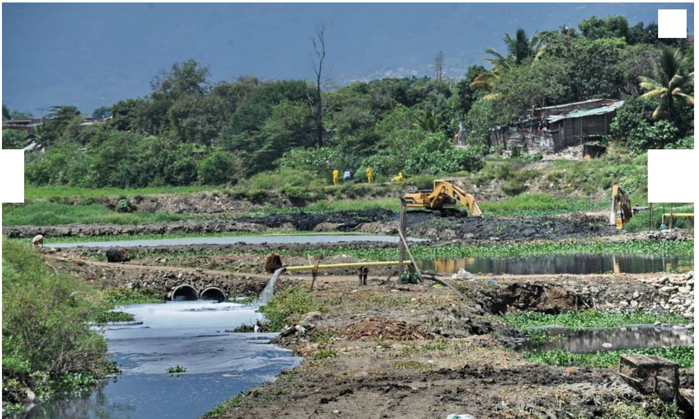
Recuperación de la Laguna del Pondaje, humedal en el oriente de la ciudad. Foto: Oswaldo Páez / El País
