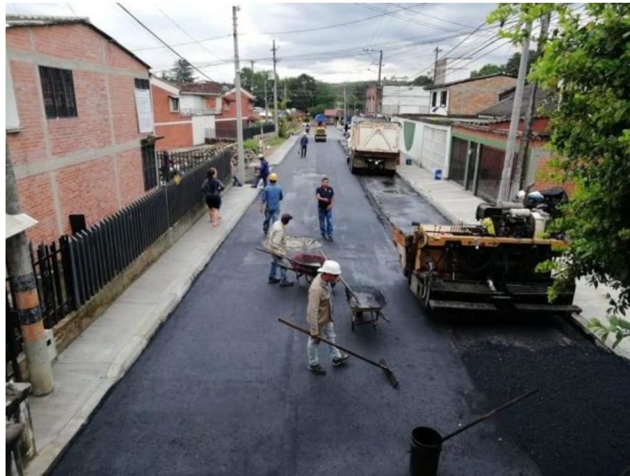
Los habitantes del sector Lácteos, específicamente en la calle 48 N, entre carreras 5 A y carrera 5 fueron beneficiarios del programa 'Pavimento en tu barrio'. / Suministrada – El Nuevo Liberal
