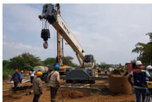
Los encargados de la obra entregaron detalles de la fundición, la cual tuvo una capa de 22 centímetros de espesor de concretos premezclados, guabinas y base granular.
