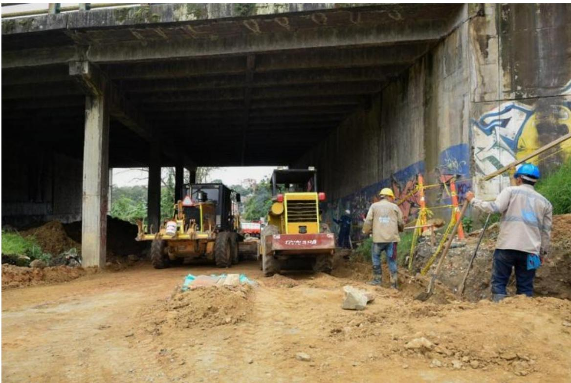
Con el traslado de las redes de Alcanos y modernización de tubería de acueducto y alcantarillado, avanza la construcción de esta vía que conectará las comunas 6, 7 y 8.
