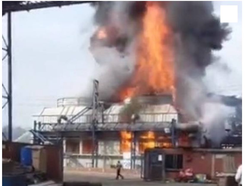
La emergencia se presentó en la torre de enfriamiento de agua. Pantallazo de video
