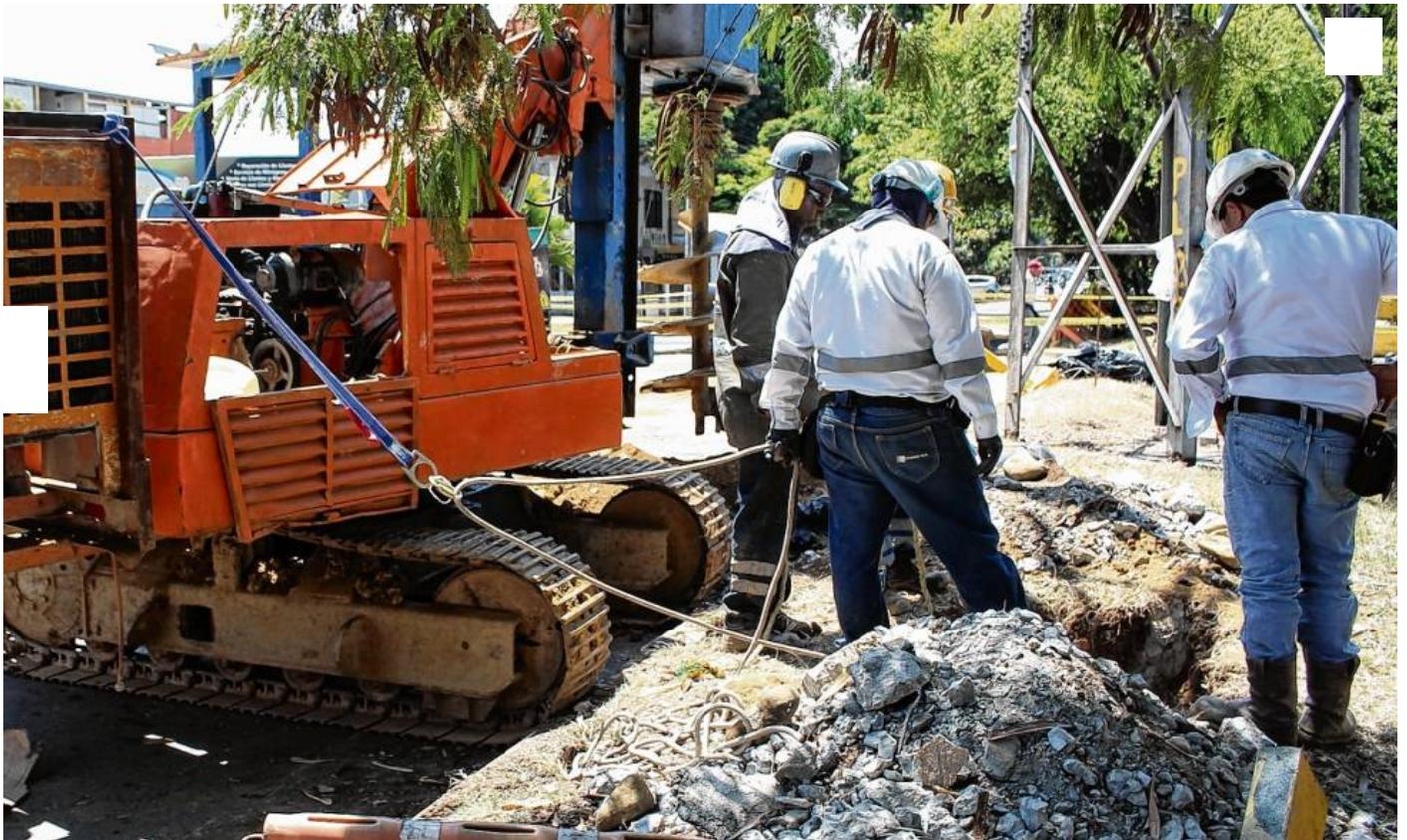
Los trabajos incluyen obras civiles como el pilotaje de las estructuras de soporte que tendrán las nuevas redes de distribución de energía. Emcali indicó que en algunas ocasiones habrá restricciones viales y en el servicio.
