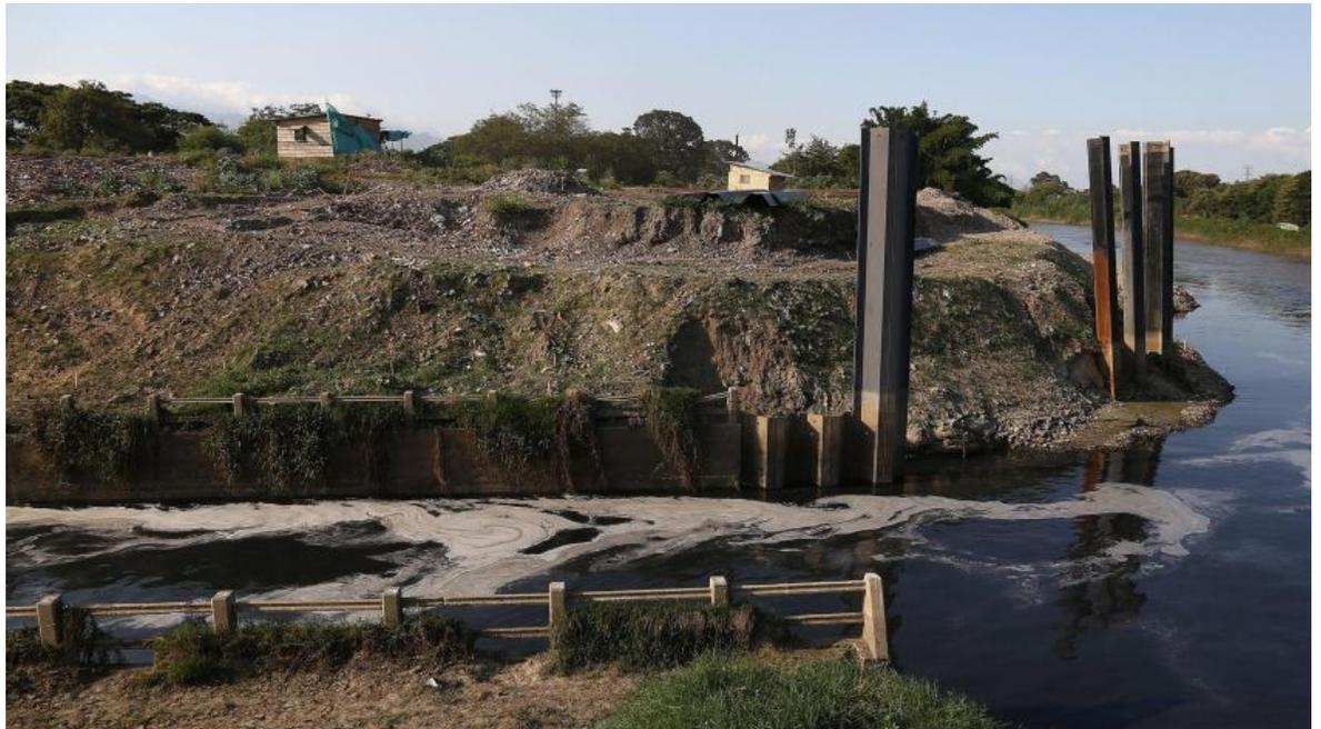
Estas son columnas que se entierran, según el 'Plan Jarillón', para formar una barrera contra la erosión del río
