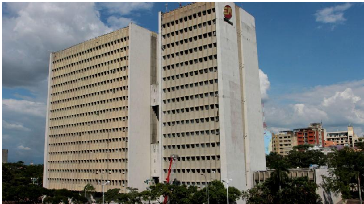
Instalaciones de las Empresas Municipales de Cali (Emcali).
