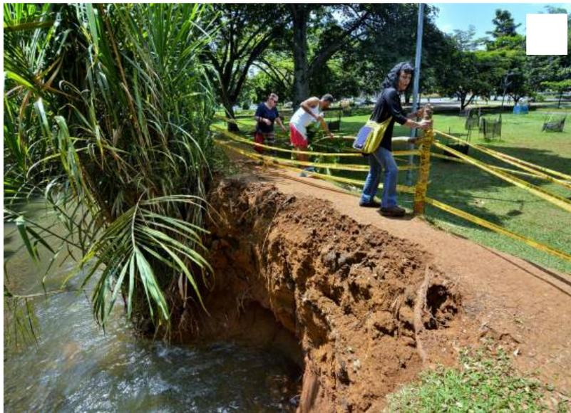
*En la imagen se puede apreciar como la corriente del agua está socavando la parte inferior del dique del río Meléndez.
