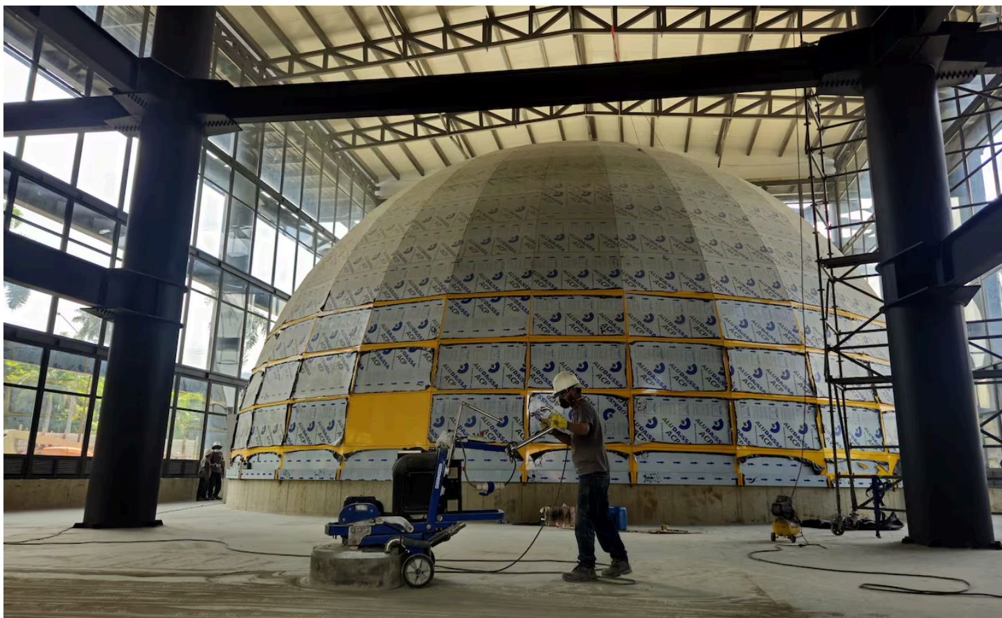
La construcción se está haciendo en el antiguo Club San Fernando, sobre toda la Calle Quinta, en frente del HUV. | Foto: Raúl Palacios
