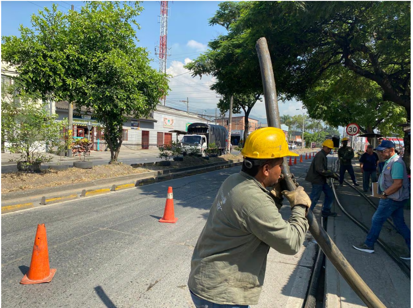
Las obras en Cali se realizan por medio de contratistas. | Foto: Cortesía de Emcali.
