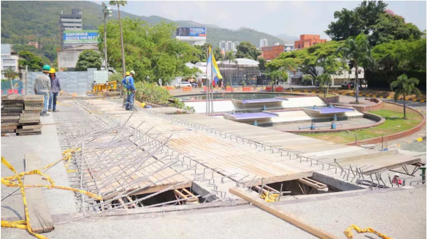
Obras del puente vehicular de la Calle 15N con Avenida 2N. | Foto: Alcaldía de Cali
