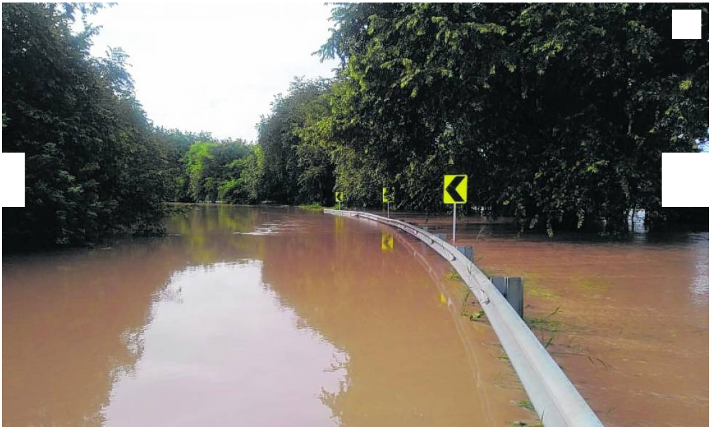
En Roldanillo las lluvias han provocado el bloqueo de la vía que conecta este municipio con Armenia, en el sector Los Quintos. Foto: Cortesía Gobernación del Valle
