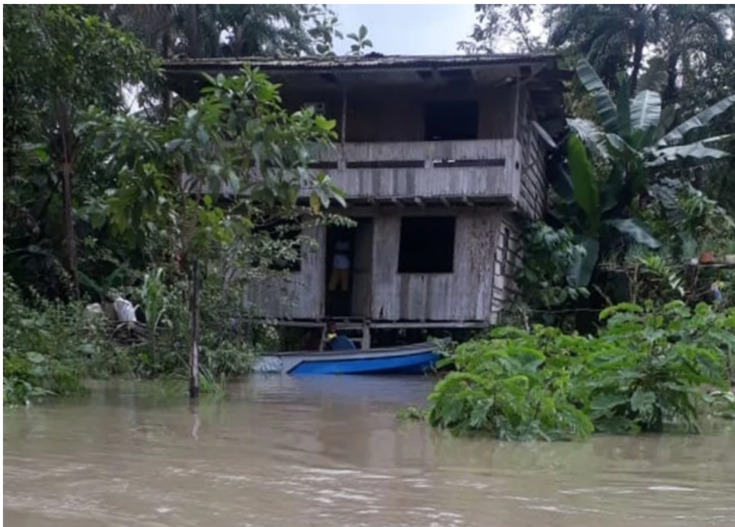
Árboles caídos e inundaciones en varias vías por las fuertes lluvias Imagen Suministrada
