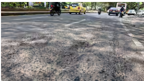
Iniciaron obras de enlucimiento del centro de Cali para la COP16
