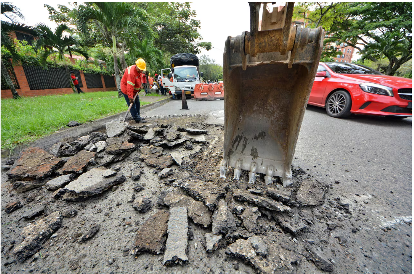
La Secretaría de Infraestructura de Cali ha iniciado un proceso de recuperación de diferentes vías de la capital vallecaucana. | Foto: Jorge Orozco
