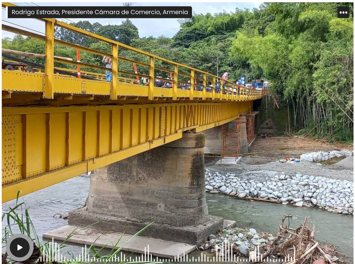
Puente Barragán que comunica al Quindío con el Valle del Cauca. Foto Vanessa Porras
