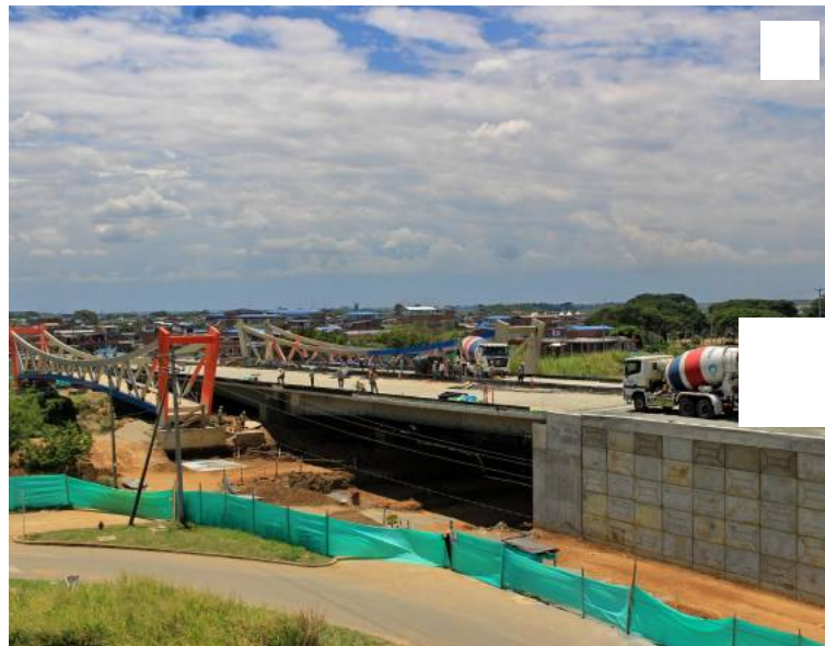
Los puentes vehiculares para conectar las carreras 50 y 80 tienen una longitud de 140 metros, mientras que los peatonales miden la mitad (70 metros). Bernardo Peña / El País
