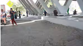
Así quedó el puente de la carrera 1 con calle 70 de Cali tras ser renovado
