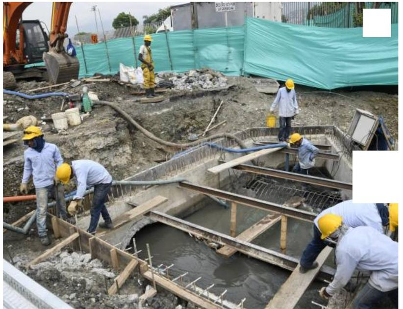
En el sector intervenido, frente a la Clínica Nuestra, se están realizando obras para terminar la construcción de una cámara (tanque en concreto). Posteriormente se realizarán trabajos de pavimentación y se pasará a la calzada auxiliar.
