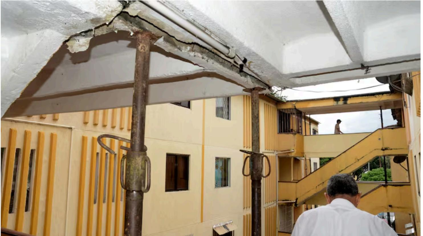
Con gatos hidráulicos sostienen la estructura en cada piso de las tres torres. Aun así, las grietas han ido ampliándose con el paso del tiempo | Foto: El País
