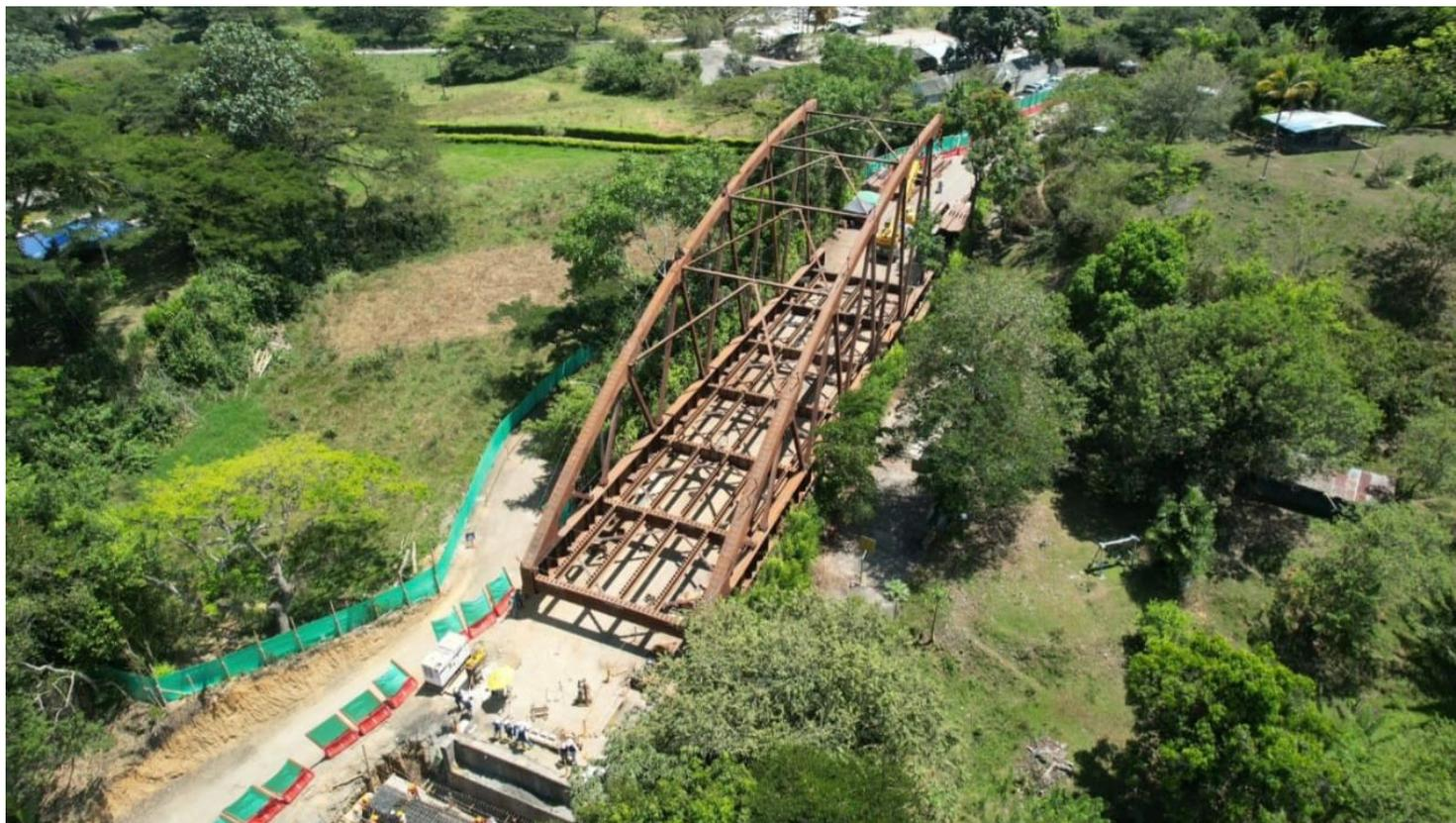
La Gobernación del Valle del Cauca señaló que la estructura del puente de El Alambrado consta de 14 secciones y a la fecha se han armado 10, que corresponden a 82 metros de los 102 totales de los que consta el puente. | Foto: Gobernación del Valle
