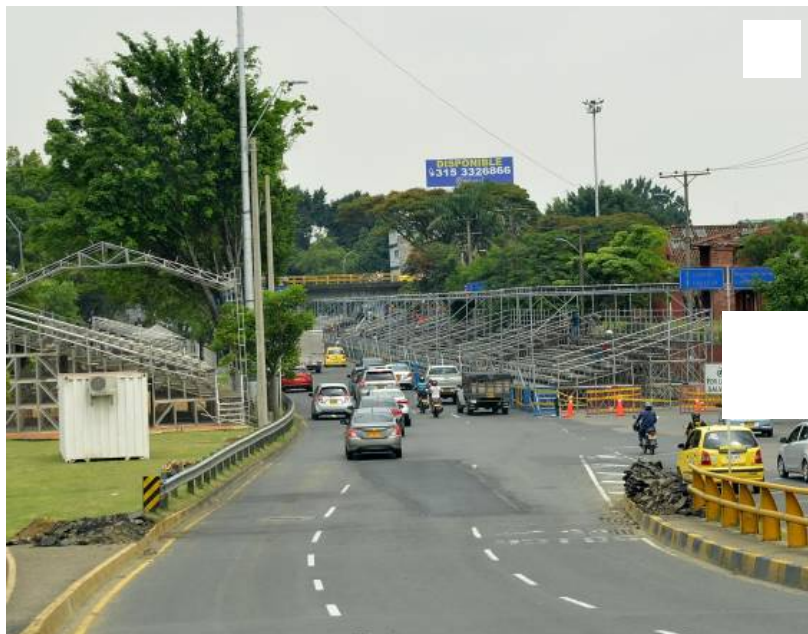
La semana pasada inició la instalación de las graderías para la calle de la Feria de Cali, ubicada en la Autopista Suroriental entre carreras 56 y 39. Wirman Ríos / El País
